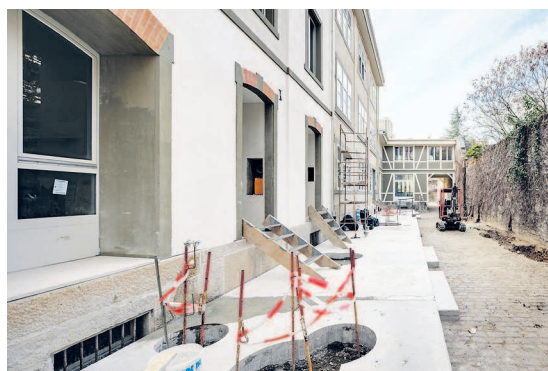
Im Innenhof werden noch die Terrassen der Wohnungen fertiggestellt. Foto: Michael Fritschi, foto-werk gmbh.
