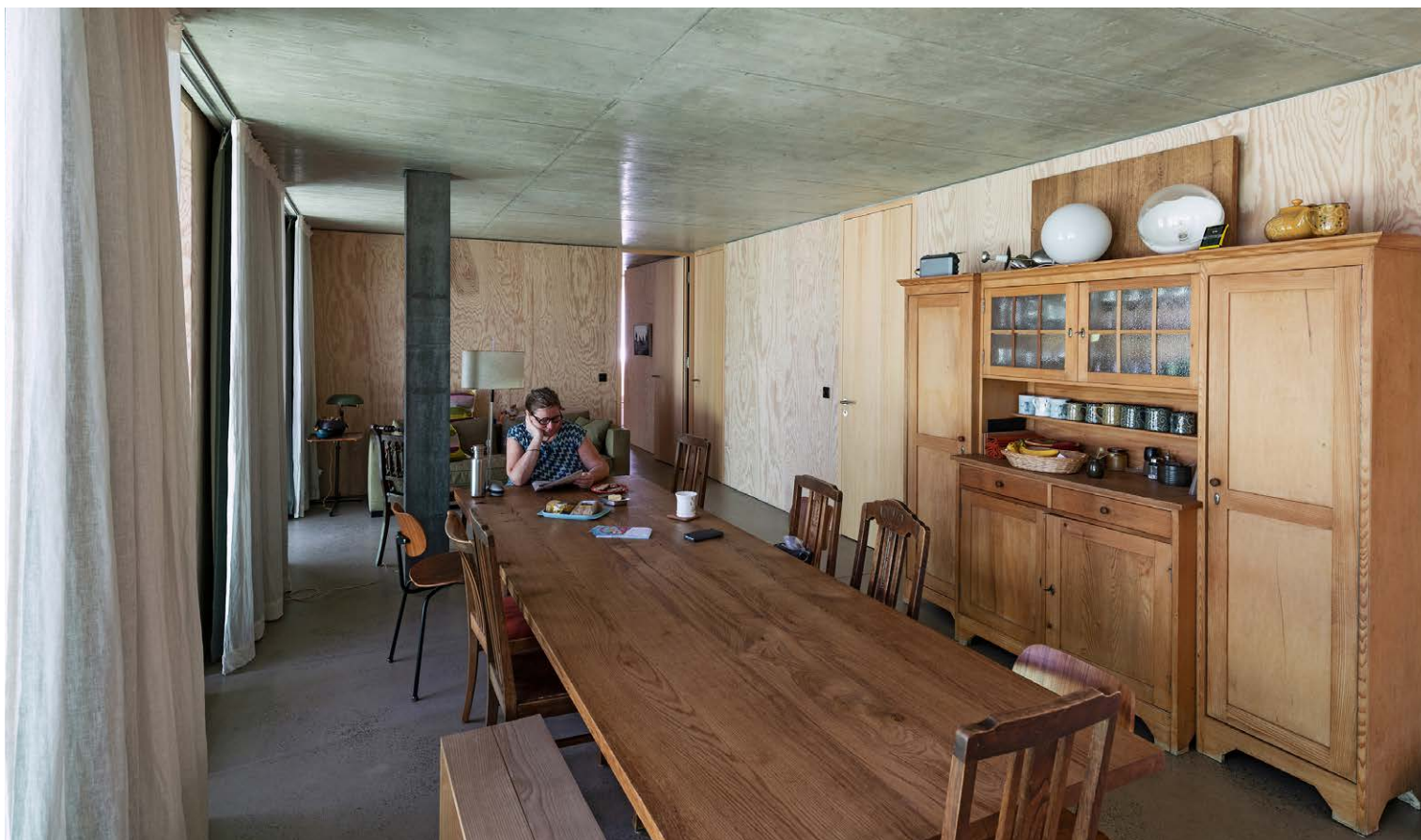
Das Esszimmer im Cluster. Eines der Schlafzimmer liegt direkt am gemeinsamen Essbereich. Der Anschluss zwischen der Betondecke und den Zimmerwänden aus Holz war zu wenig schalldicht.
