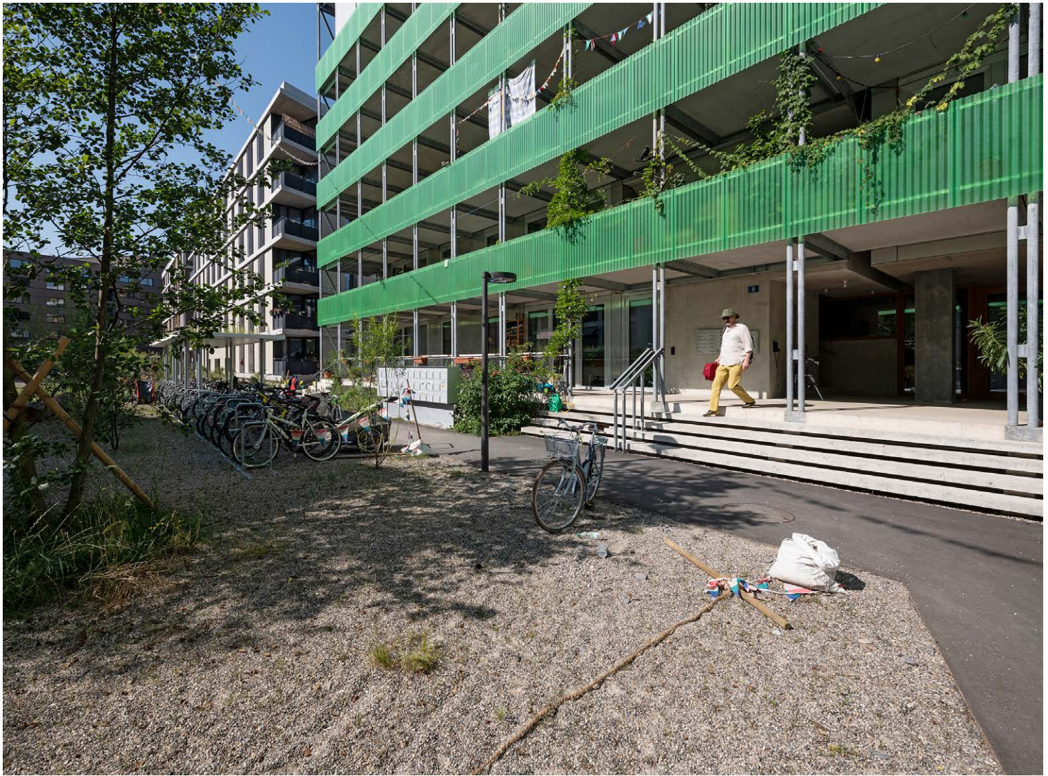
Beim Haupteingang weitet sich der Laubengang zu einem gedeckten Vorplatz, der Aussenlobby.
