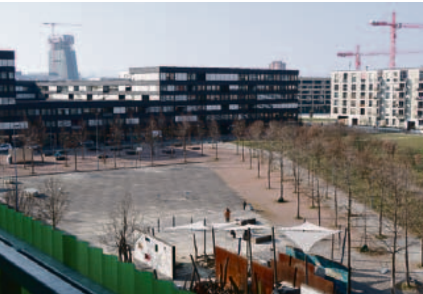
Das erste Gebäude der Erlenmatt, das Erlentor. Rechts das Baufeld E. (Foto: Markus Vogt)
