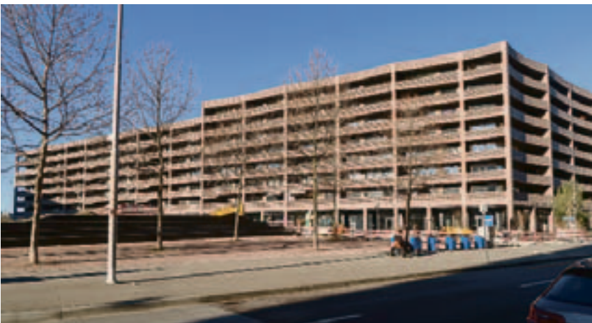
Das Bâleo-Gebäude von der Erlentor aus gesehen. (Foto: Markus Vogt)
