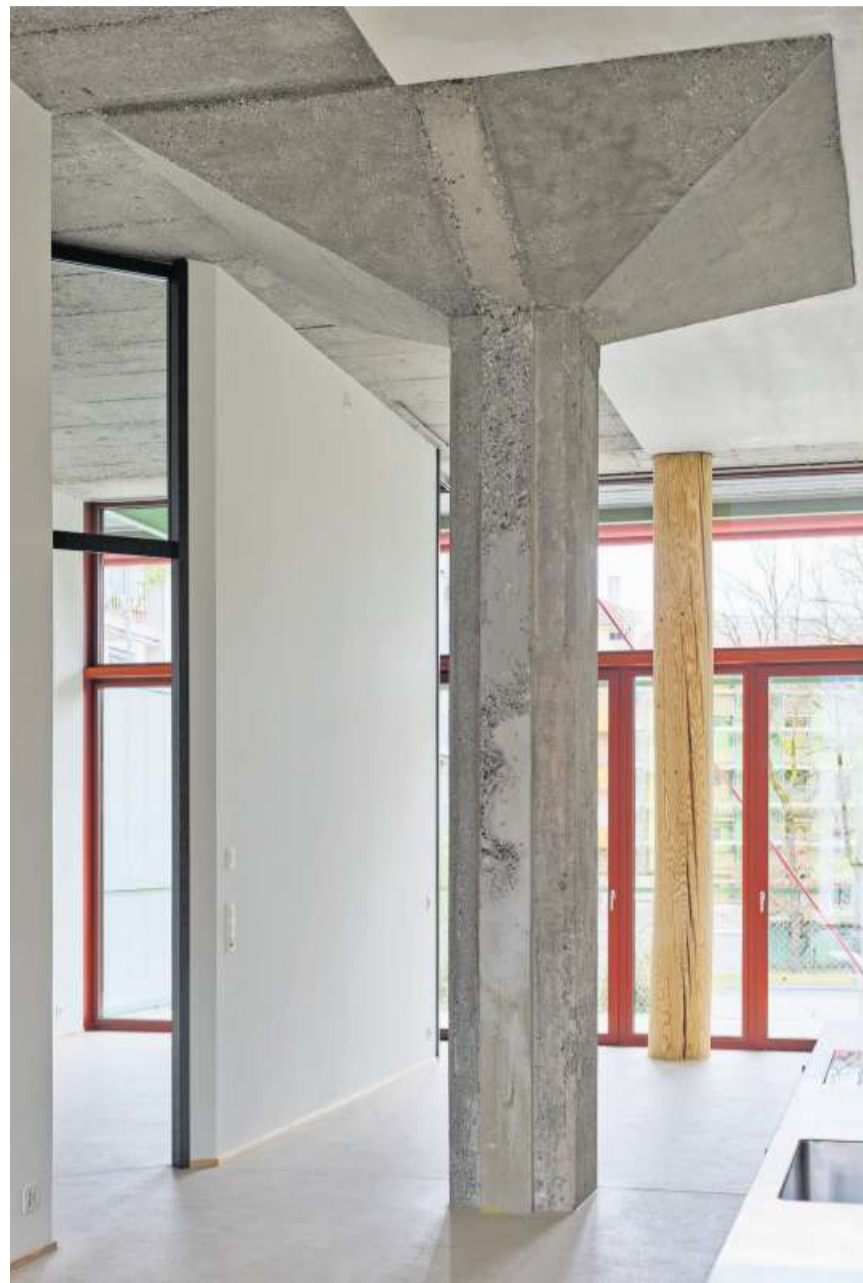
Die pilzförmigen Betonstützen stehen im umgebauten ehemaligen Weinlager als stumme Mitbewohner mitten im Raum.
