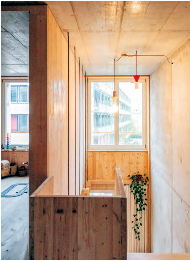
Eine Hülle aus Beton und Backstein fasst das Innenleben aus Holz.
