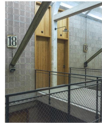
Über Laufstege sind die Zimmer an den Aussenseiten des Gebäudes im zweiten Obergeschoss erschlossen.
