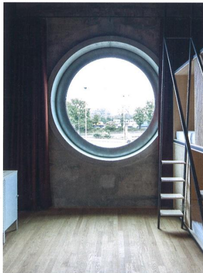
Hostelraum im 1. Obergeschoss. Aus Lärmschutzgründen können die Fenster zur Strassenseite hin nicht geöffnet werden.
