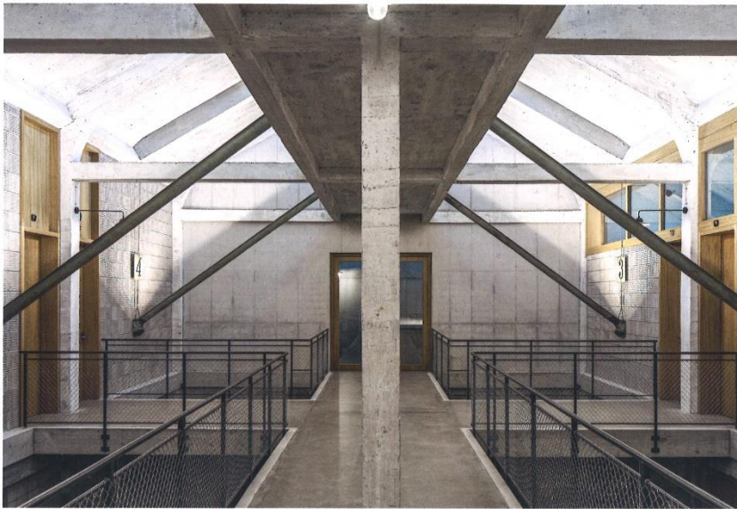
Zweites Obergeschoss des Silogebäudes mit Blick in die offenen Silobehälter.
