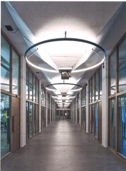
Der Korridor im Erdgeschoss mit den Silotrichtern, die von kreisförmigen Beleuchtungskörpern eingefasst sind.
